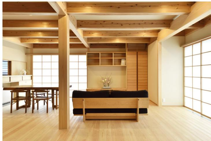
リビングは杉と松の力強い架構を見せています。大黒柱は松の6寸角（180mm角）です。梁は節がたくさんある一等材ですが、目線の低い位置は、節の少なめの材料を用いて落ち着いた印象にしています。床は松のフローリング（特選上小節）です。松の障子は棧を細くして、すっきりとした印象に仕上げています。
