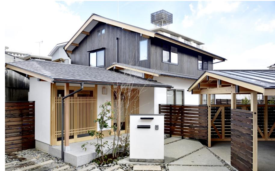
1階部分の壁は漆喰仕上げ。2階部分は杉板（外壁用パネリング）で、水に強い赤身材を使用しています。黒く塗装することで、高さを抑えた印象にしています。
